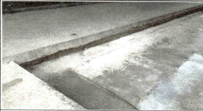
Foto 7: Reparación de banquetas de concreto
