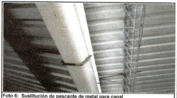
Foto 6: Sustitución de pescante de metal para canal
