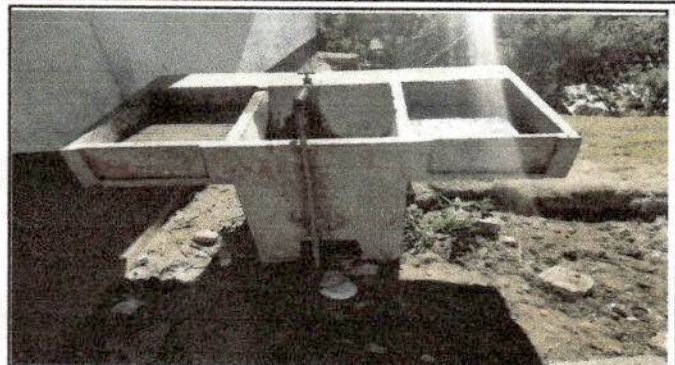
Foto 20: Sustitución de pileta de cemento de dos lavaderos
