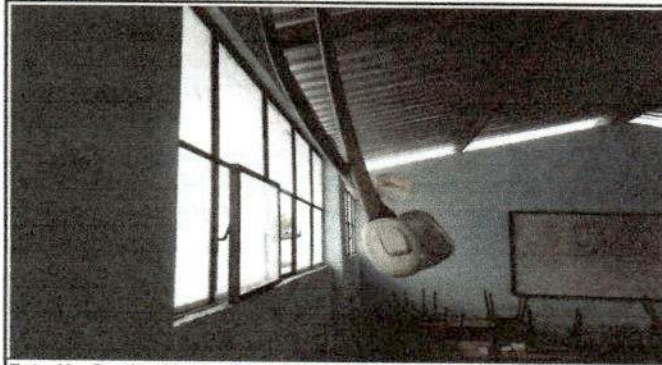
Foto 19: Sustitución de ducto electrico
