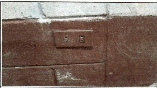
Foto 15: Sustitución de tomacorrientes dobles
