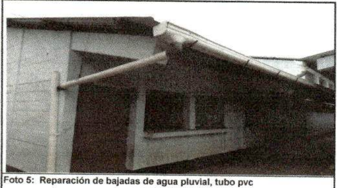
Foto 5: Reparación de bajadas de agua pluvial, tubo pvc
