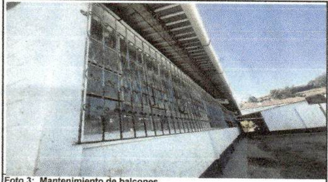
Foto 3: Mantenimiento de balcones
