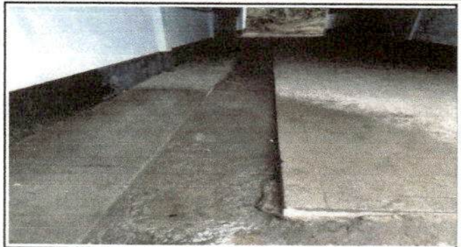
Foto 8: Reparación de cuneta de concreto
