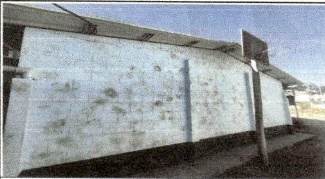
Foto 9: Metros de pintura en muros exteriores e interiores
