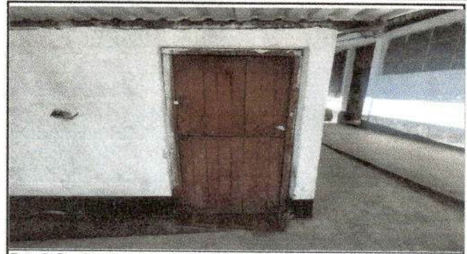
Foto 2: Sustitución de puerta de madera a metal
